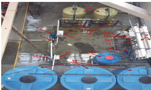
1 сурет - «Аквамин ОУВ-18» - жабдықтарының орналасу құрылымы.
