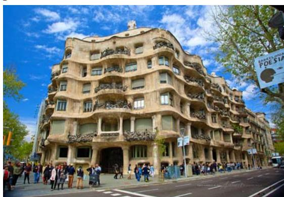
В доме Мила применены новые конструктивные решения: отсутствуют внутренние несущие стены, все междуэтажные перекрытия поддерживаются колоннами и наружными стенами, в которых балконы играют конструктивную роль [3]. Это одна из первых попыток создать новое планировочное решение, известное впоследствии как "свободный план". На крыше дома установлена терраса-кровля с вентиляционными трубами, шахтами, лестницами, имеющими сложное пластическое решение биоморфного характера.
